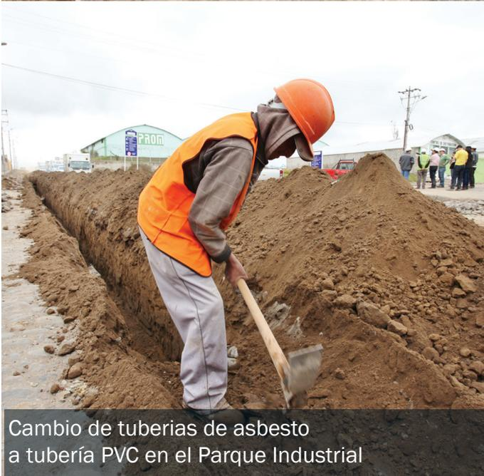
Cambio de tuberías de asbesto a tubería PVC en el Parque Industrial
