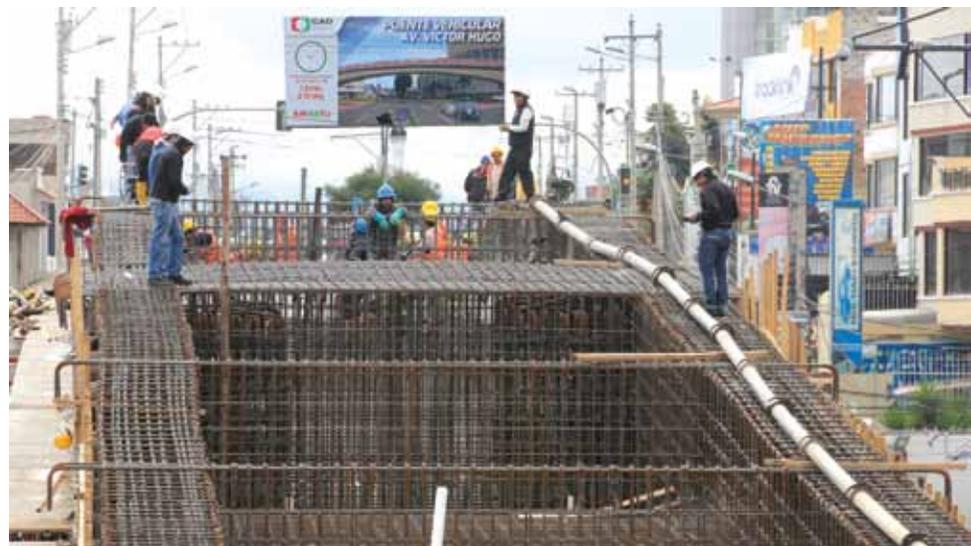
La primera losa tiene 30 centímetros de espesor; la próxima semana se prevé fundir las vigas y el diafragma del puente.
