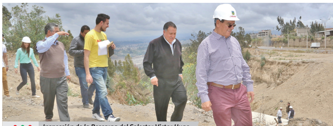
● ● ● Inspección de la Descarga del Colector Victor Hugo
